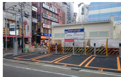
施設内に新設した駐車場
