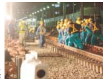
夜間に行われる線路の切り替え作業
