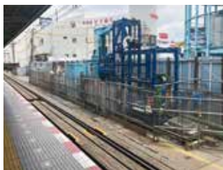
基礎杭打設工事状況
