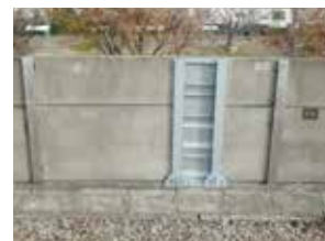
高架橋の高欄改修の様子
