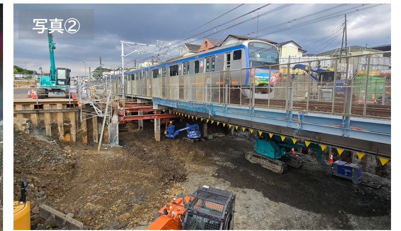
▲ 工事桁によって昼間でも掘削が可能になりました
