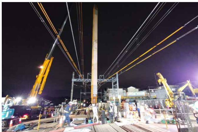
シールドマシンを発進させる坑道をつくるための基礎工事の様子。終電後にいったん線路を取り外し、土留めの工事を実施した
