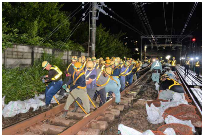
2024年6月に行われた線路の切り替え作業の様子。機械による施工が難しい場所だったこともあり、総勢約170人による人力で作業が行われた
