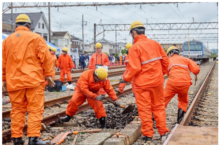
「異常時総合訓練（2024 年度）」 損傷箇所の早期復旧訓練の様子
