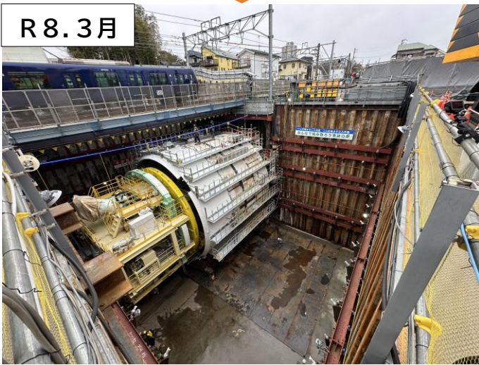
重さ1200 tのシールドマシンは、底に小さな玉がついた台に載せて、滑らすようにして動かしています。
