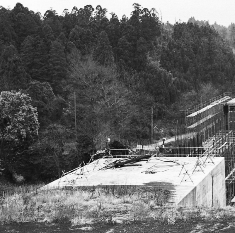
開削トンネルが伸びる、いずみ野線工事風景(1974年12月)
