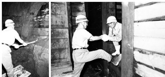
〔左3枚〕岡津トンネル貫通 （いずれも1973年5月）
