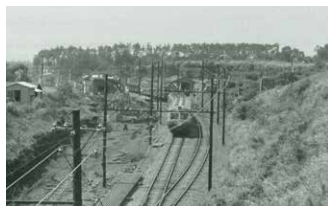
複線工事中の三ツ境駅付近
