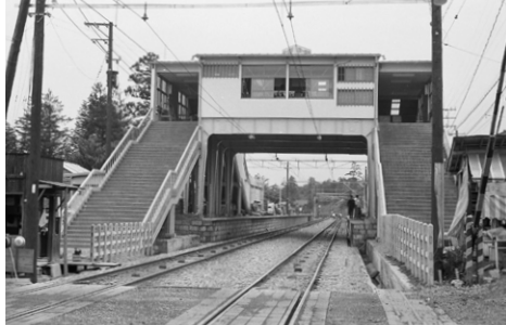
相鉄線初の橋上駅舎となった鶴ヶ峰駅（1962年）
