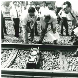
ATS（自動列車停止装置） の設置（1968年～）
