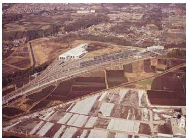
かしわ台電車基地全景
