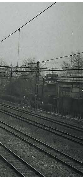
複線化工事が始まる (写真は平沼橋～西横浜間)
