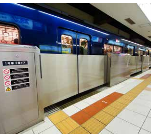
ホームドア設置
