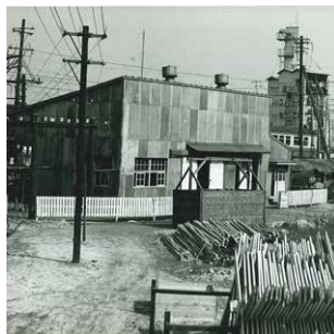
西横浜変電所を新設
