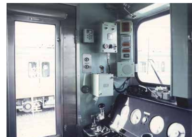
列車誘導無線装置設置（1970年～）
