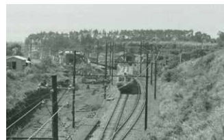
複線工事中の三ツ境駅付近
