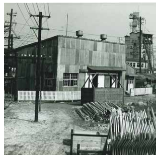
西横浜変電所を新設
