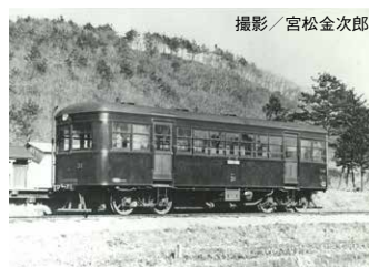
神中鉄道が製造した気動車キハ31。ディーゼルエンジンを搭載し、横浜～西谷間の電化まで活躍
