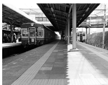
駅ホームに点字ブロックを設置（1974年、二俣川駅）
