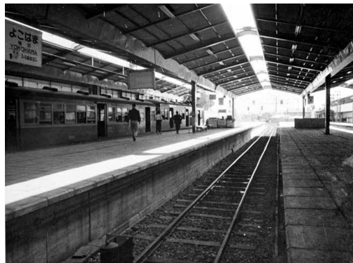
横浜駅西口開発に合わせて完成した相鉄線横浜駅新駅舎、ホーム (1956年)
