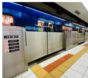
ホームドア設置
