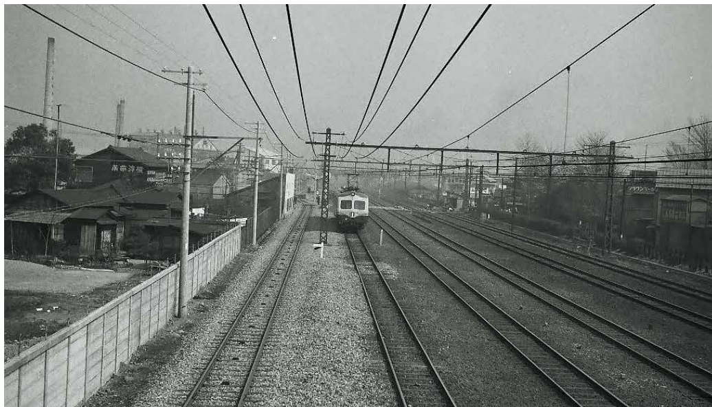
複線化工事が始まる (写真は平沼橋～西横浜間)
