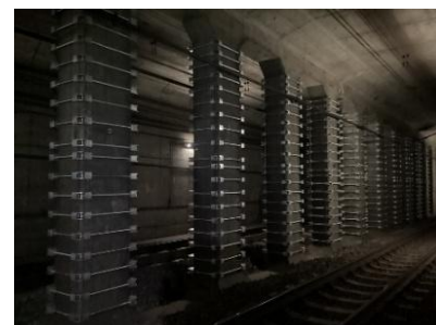
耐震補強された柱 (万騎が原トンネル)
