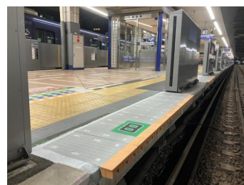
隙間対策を施したホーム先端
